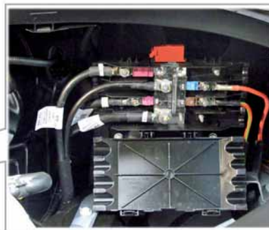
SH-Sicherungen im Motorraum links
